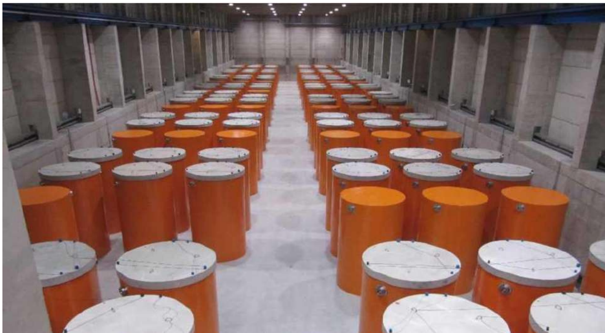
Рисунок 3.2-3. Зал хранения бочек ОЯТ в ВХОЯТ-2.
