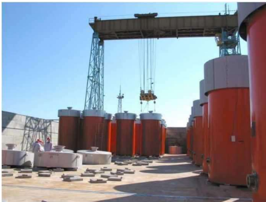
Рисунок 3.2-1. Хранилище отработанного ядерного топлива ISFSF-1 с контейнерами.
