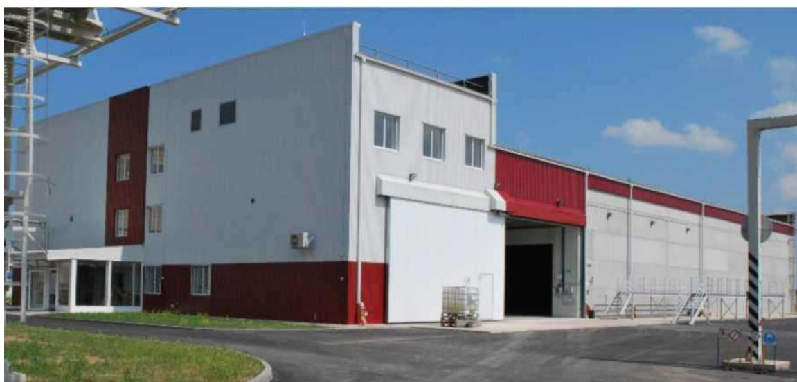
Рисунок 3.2-26. Здание накопительного хранилища ОВНН
