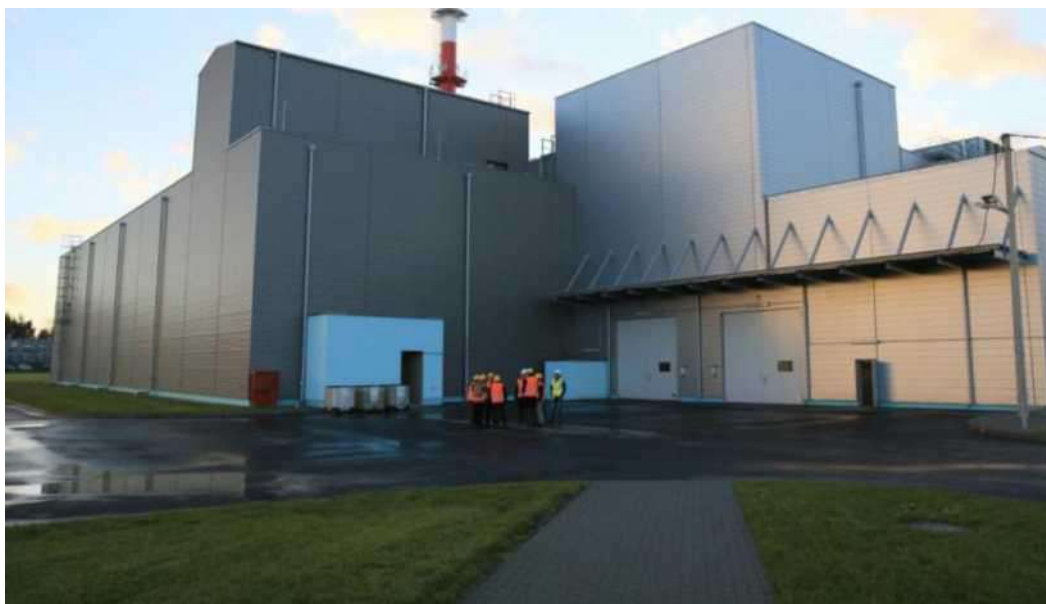
Рисунок 3.2-22. Объект ИАЭС по переработке и хранению твёрдых радиоактивных отходов (ОПХТРО)
