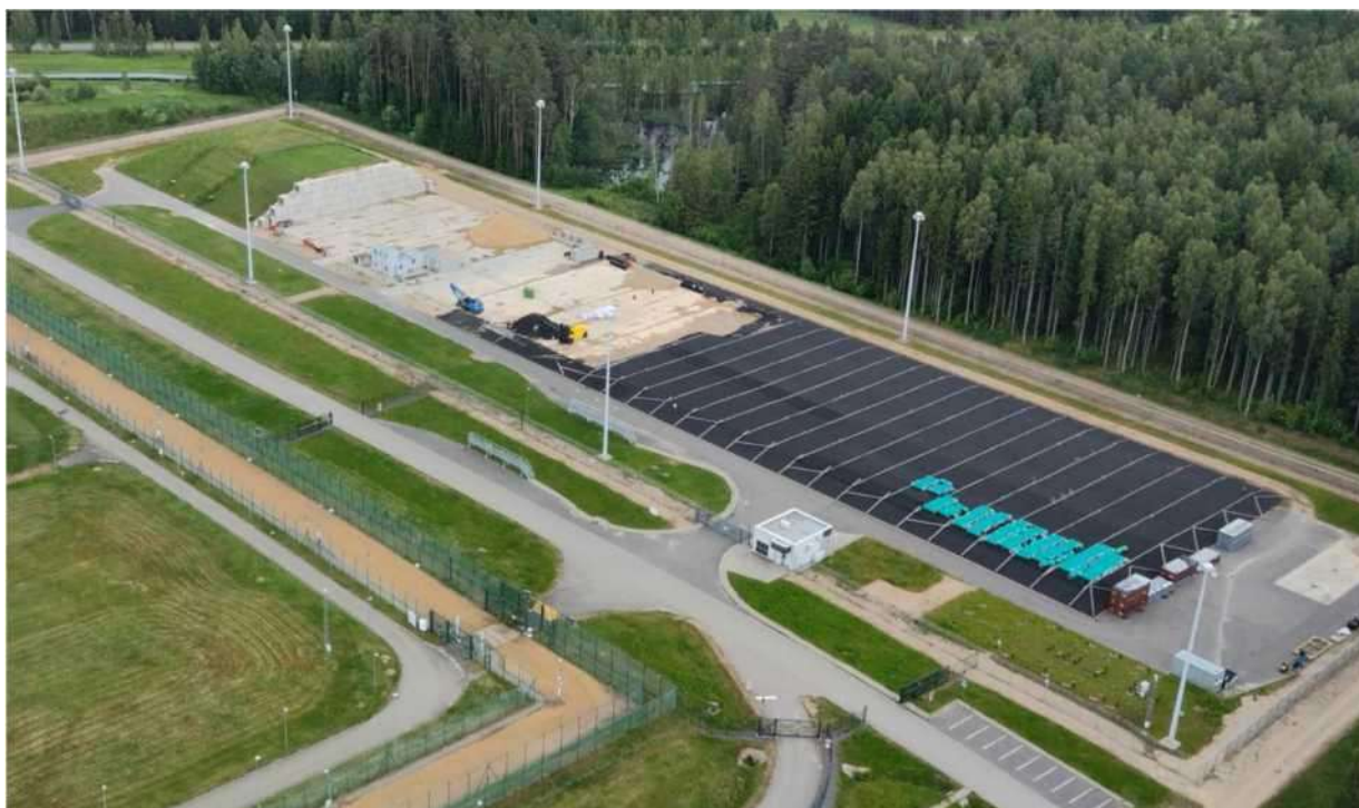
Рисунок 3.2-29. Модуль хранилища ОВНН с сформированными инженерными барьерами и защитной стеной после проведения отдельной кампании размещения
